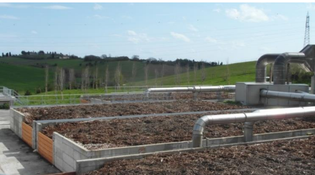
Figura 30 Biofiltro
