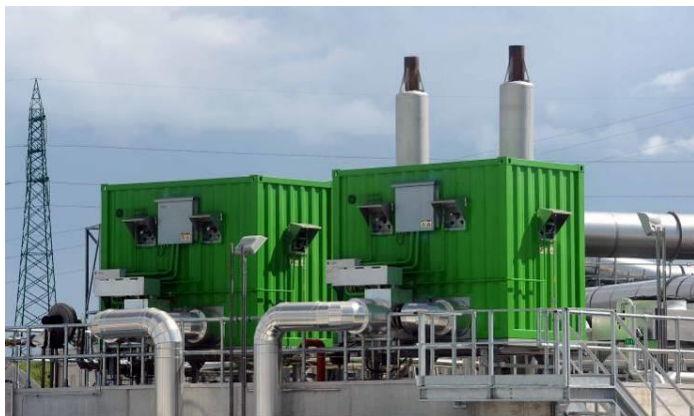
Figura 32 Punti di emissione cogeneratori (E5, E6)
